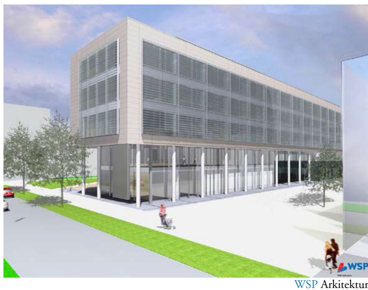
Figur 4.5 Söder- och västerfasad (fönsterandel 69% resp. 44%) med enkelskalsfasad med yttre rörlig solavskärmning, såsom den planerades under systemskedet.
