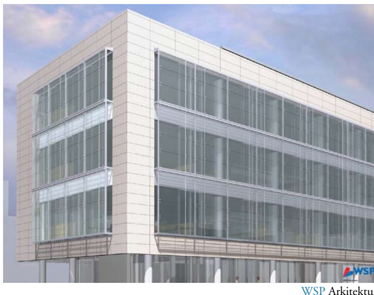
Figur 4.7 Söder- och västerfasad med dubbelskalsfasad enligt bygghandlingarna.
