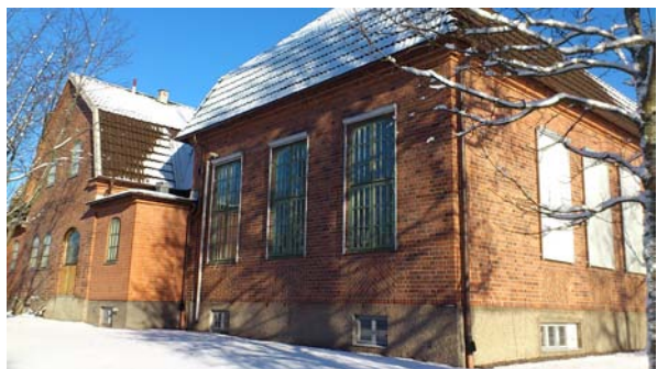
(Bild 5.3.1 Installation med screen på församlingshem från 40-talet.)
