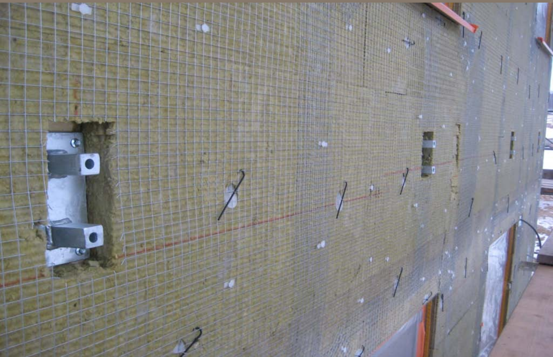
Bild 11: (Infästning av terrassmarkis).
