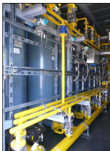
Sex PSA-kolonner separerar CH 4 och CO 2
