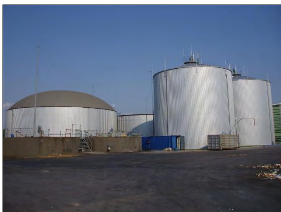
Två primära rötkammare av stål (till höger) och sekundär rötkammare med gaslager (till vänster)
