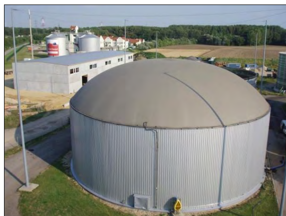
Sekundär rötammare och gaslager
