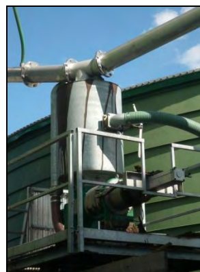
Separering av den fasta rötresten
