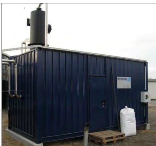
Kemisk-oxidativ skrubber från utsidan
