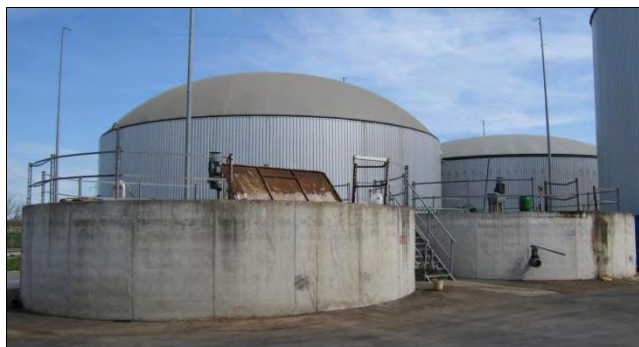
Tankar för krossning av råmaterialet (längst fram)
