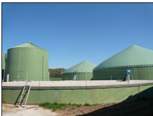
Tre utvecklingsfaser av rötkammare: (i) Bak till vänster, Lipp GmbH, (ii) fram, självkonstruerad, (iii) bak i mitten till höger, Novatech GmbH
