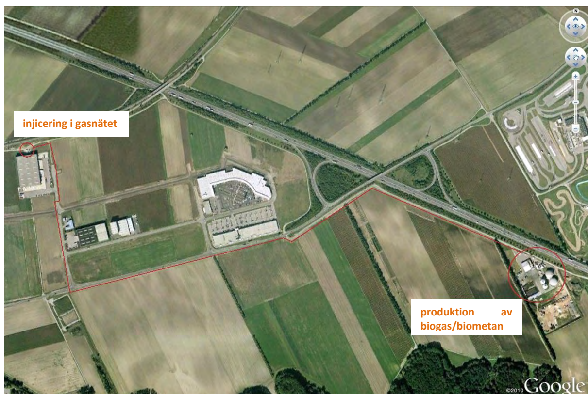
Översikt av biogasanläggningen och platsen för injicering i gasnätet (Google Earth 2012)
