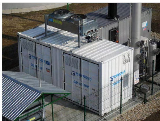
Biogasuppgraderingsenhet i ISO-container av stål Lager för biometan i gasflaskor, 200 bar
