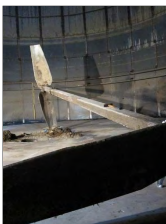
Omrörning i rötkammarens mitt
