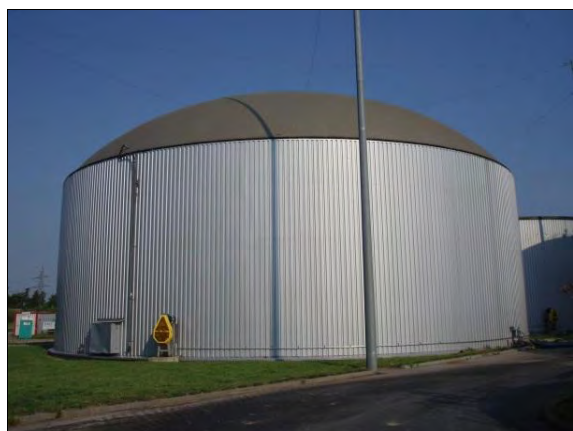
Sekundär rötammare och gaslager
