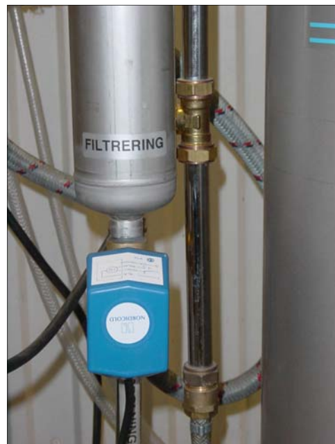
Reglermotor 2. Under syrepelaren.
