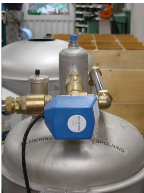
Reglermotor 1. På toppen av filtret.
