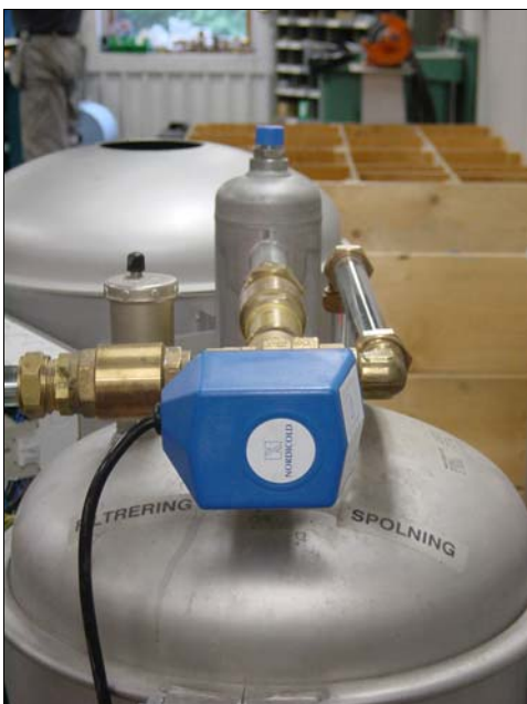
Reglermotor 1. På toppen av filtret.
