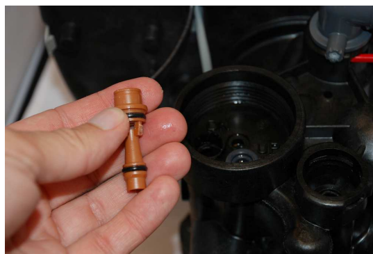
Lyft upp injektorn. Rengör injektor med mjuk borste och diskmedel. Vid byte är rätt injektorbeteckning markerad på locket. I detta fallet injektor B.
