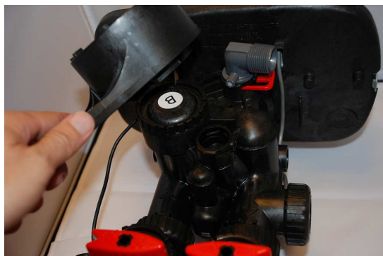
Lossa och tag bort injektorlocket med specialverktyg (tillbehör).
