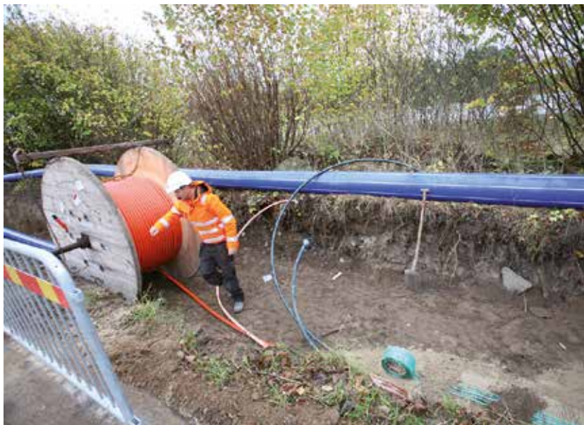
Byggandet av den nya vattenledningen från vattenverket i Bromölla till vattenverket i Olofström är i full gång och ska vara klart i april 2016.
